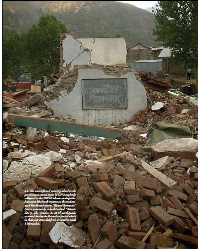
شکل شماره ۳: آثار باقی مانده از زلزله
