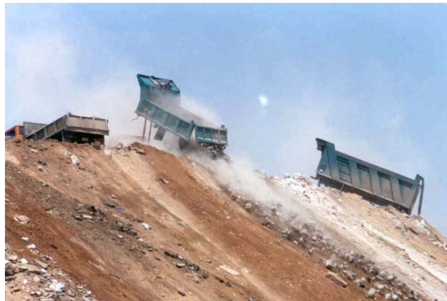
شکل شماره ۵: تخلیه نخاله های ساختمانی
