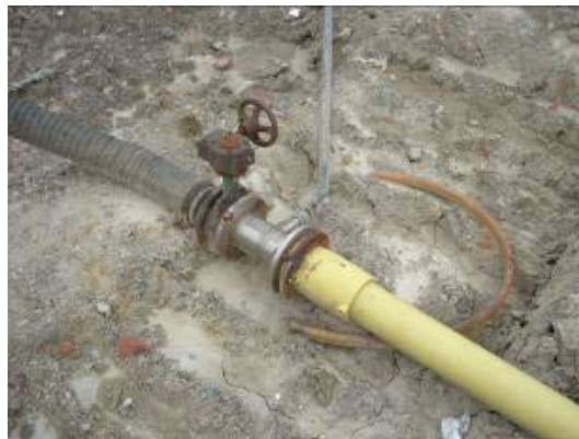
شکل ۵- حذف رطوبت از مسیر انتقال بیوگاز
