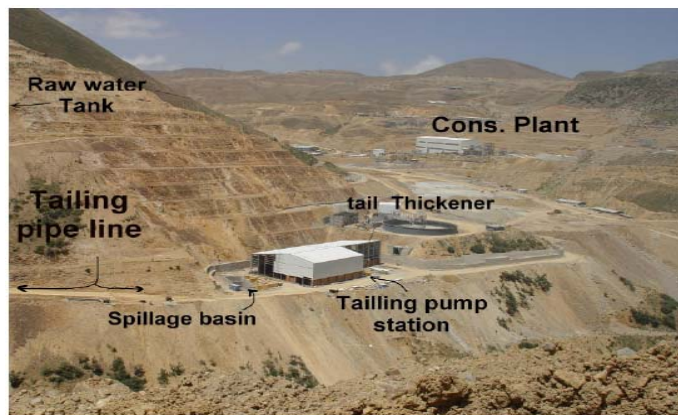
شکل (۳) نمای کلی از معدن سونگون اهر (کارخانه، تیکتر باطله، ایستگاه پمپاژ و ...)
