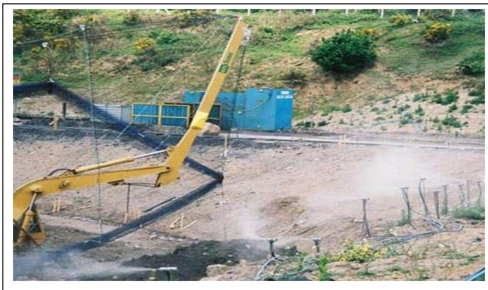
شکل ۱: استفاده از دستگاههای پرتابل تزریق کننده مواد شیمیایی در محل دفن
