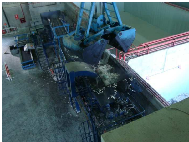
شکل (۱): نمایی از خط RDF- اجرا شده توسط شرکت Satrind ایتالیا
